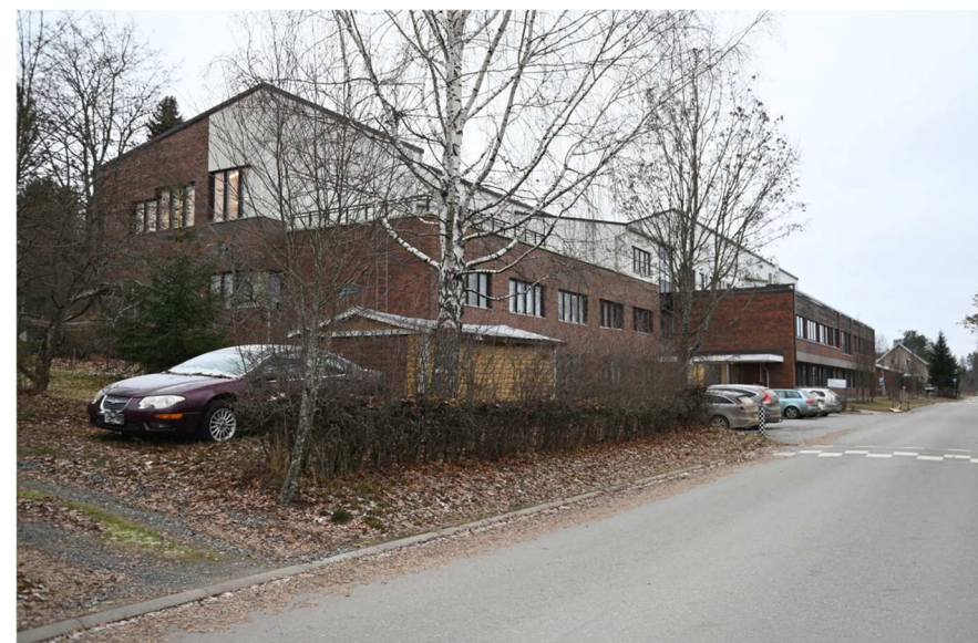
Kuva: Lähemäkitalo. Vanhan puolen katto on yhtenäistä pulpettikattoa, toisin kuin piirroksessa.
