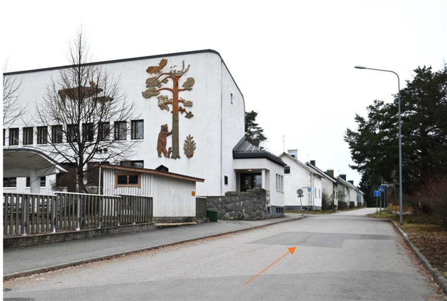
Kuva: Lähemäenkadun puolella katseenvangitsijana toimii arkkitehtuuriltaan edustava lastentalo, katu jatkuu kaupunkikuvallisesti eheänä. Yhdenmukaisesti sijoitetuista tyyppitaloista muodostuu katutilalle rauhallinen seinä.
