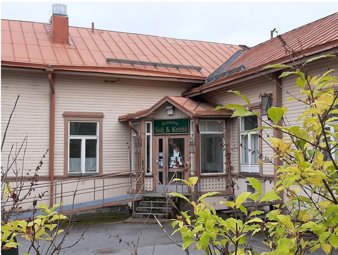
Kuva 1. Kuvassa näkyy Lähemäen entisen kansakoulurakennuksen pääsisäänkäynti.
